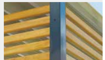
Holzbelattung Fichte waagrecht, 55 x 35 mm, lasiert im Holzfarbton Eiche
