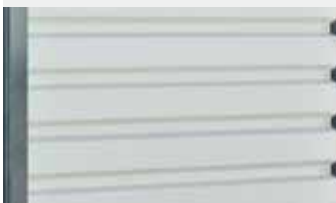
Trapezblech waagrecht, außen RAL 9002, innen Schutzlack Hellgrau
