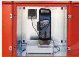
Schließfach mit Schuko-Steckdose für den Betrieb von bauseitigen Ladestationen.
