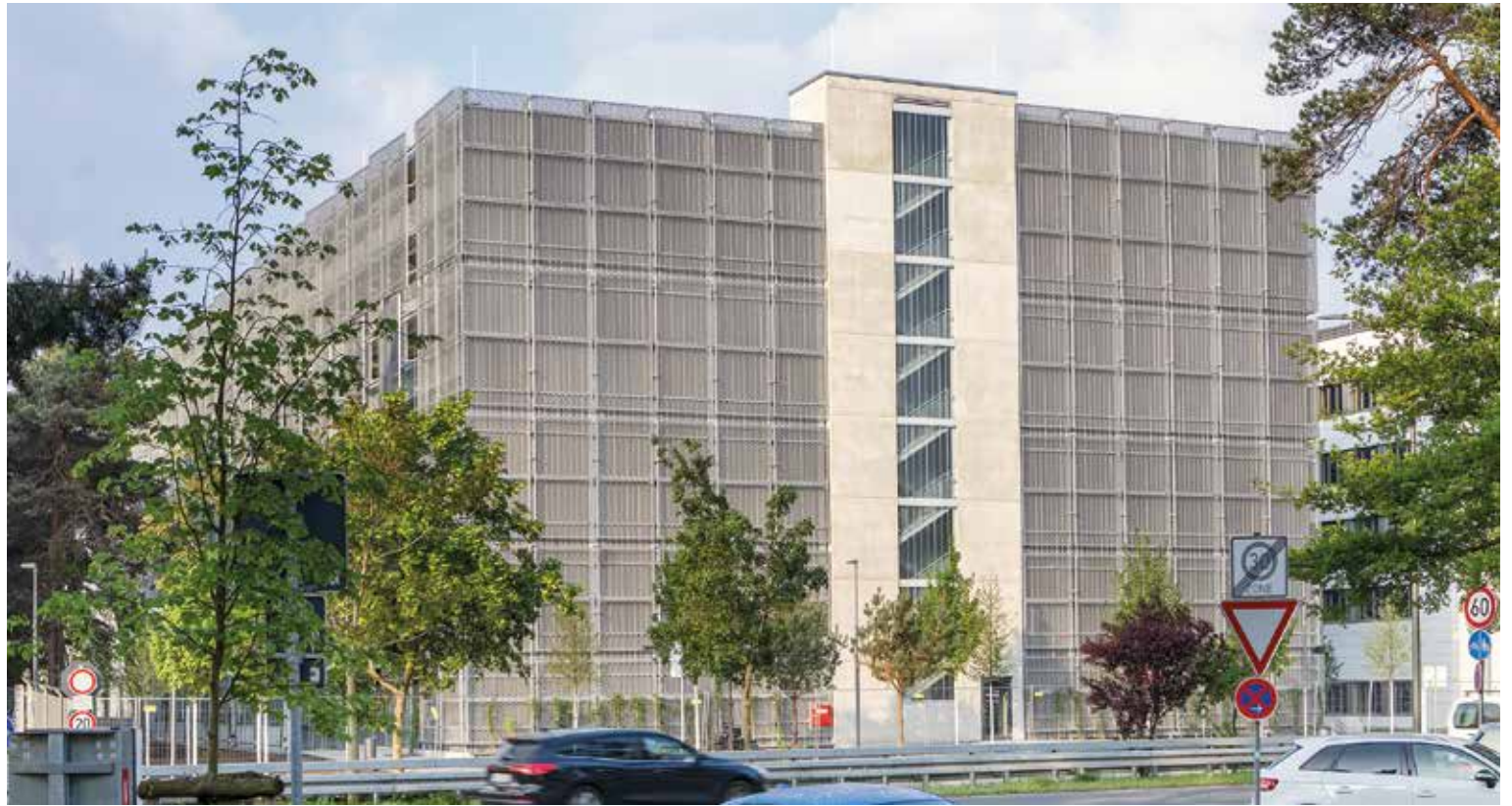
Die drei neuen Parkhäuser – hier eines davon – bieten insgesamt rund 2.300 Pkw-Stellplätze und 1.500 Fahrradstellplätze für die Mitarbeitenden von Siemens.
