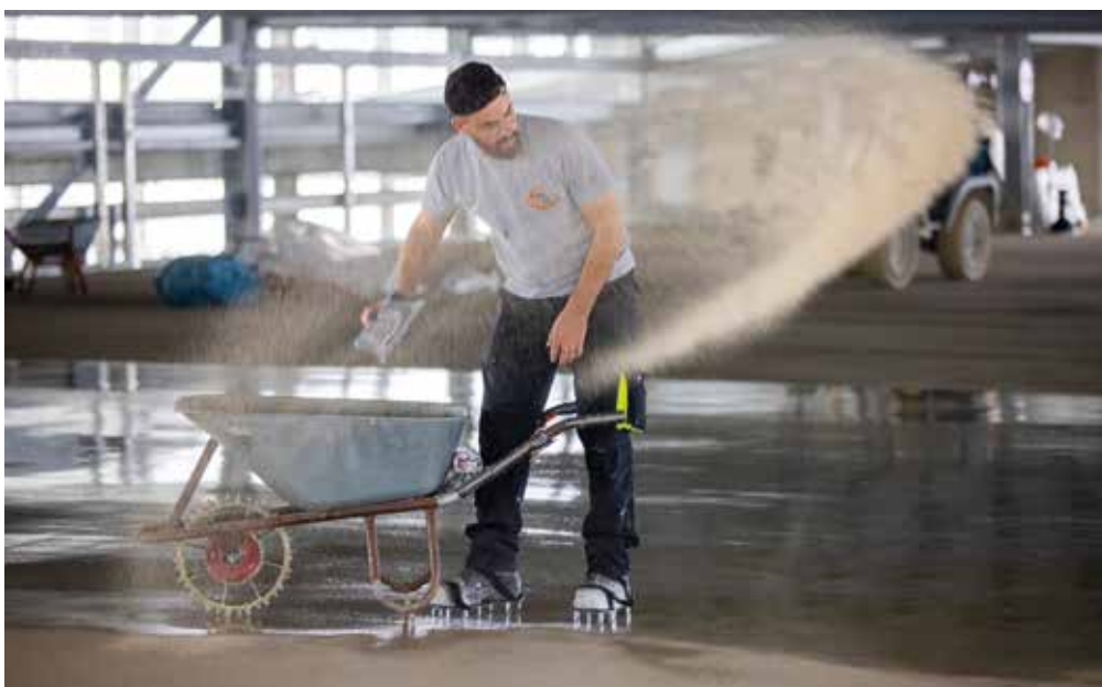
Vollsatt und gleichmäßig wurde die feuergetrocknete Quarzsandmischung Quarz 03/08 DF im Überfluss eingestreut.
