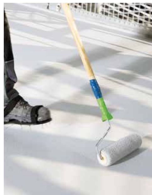
Belastbarer Schutz: Mittels Epoxy-Rollen wurde Epoxy Color Top aufgetragen.
