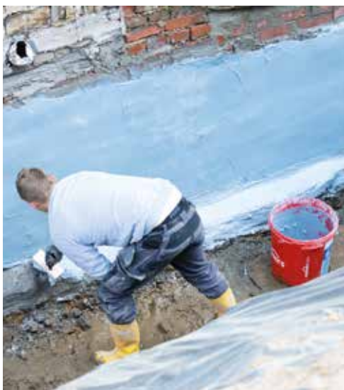
Die Gebäudesockel wurden mit Systemlösungen von Remmers vor aufsteigender Feuchtigkeit geschützt.
