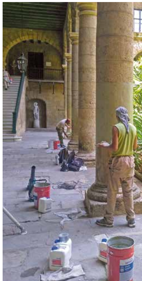
Fachgerechtes Auftragen von Clean Galena an den Säulen im Innenhof.
